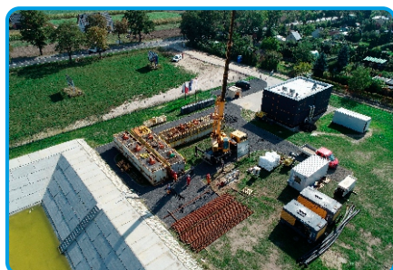
Powstająca stacja filtrów w Chojnach
