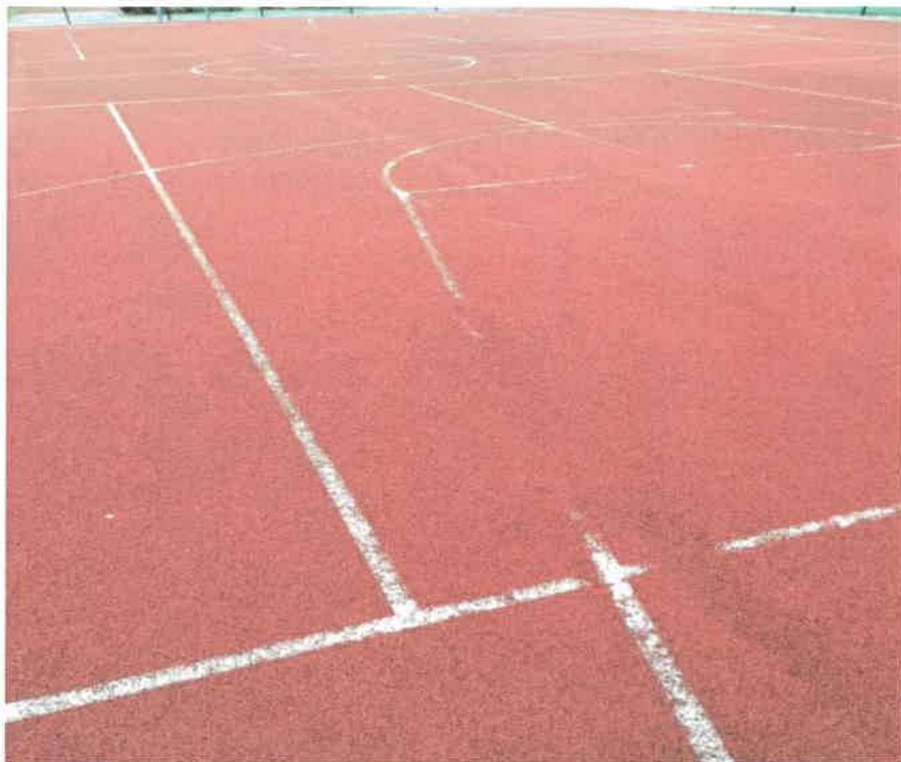
Zdjęcie nr 1. Istniejąca nawierzchnia poliuretanowa.
