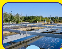
OCZYSZCZALNIA ŚCIEKÓW (ul. Energetyczna)
