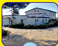
ADMINISTRACJA (ul. Energetyczna)
