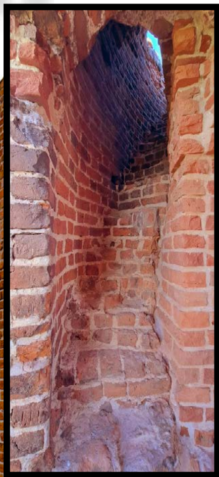
Klatka schodowa w baszcie narożnej.
