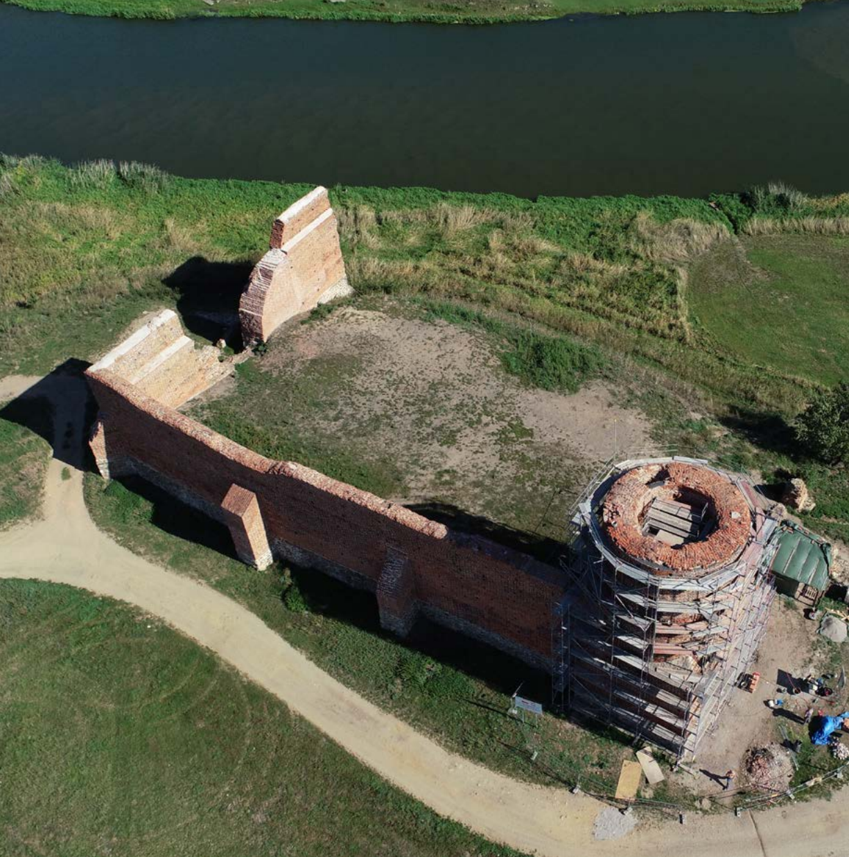
Prace konserwatorsko-budowlane przy baszcie narożnej (2023 r.).
