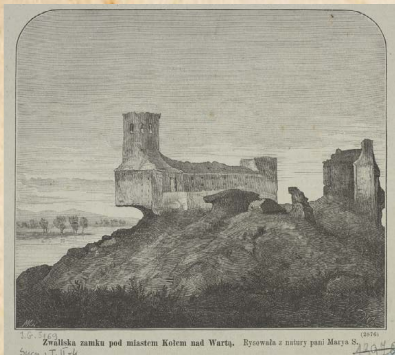
Rycina z czasopisma „Kłosy” z 1874 r. Widać na niej nieistniejący już dzisiaj fragment muru. Nie sposób też nie dostrzec poważnego ubytku fundamentu wieży narożnej.
