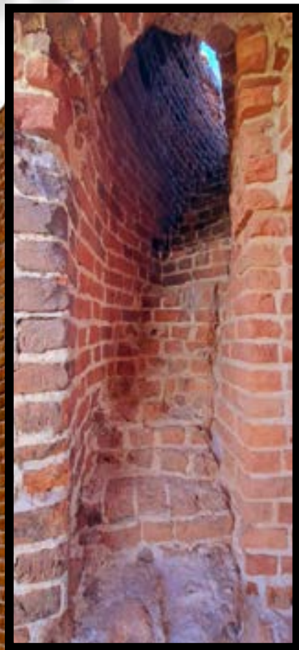
Klatka schodowa w baszcie narożnej.
