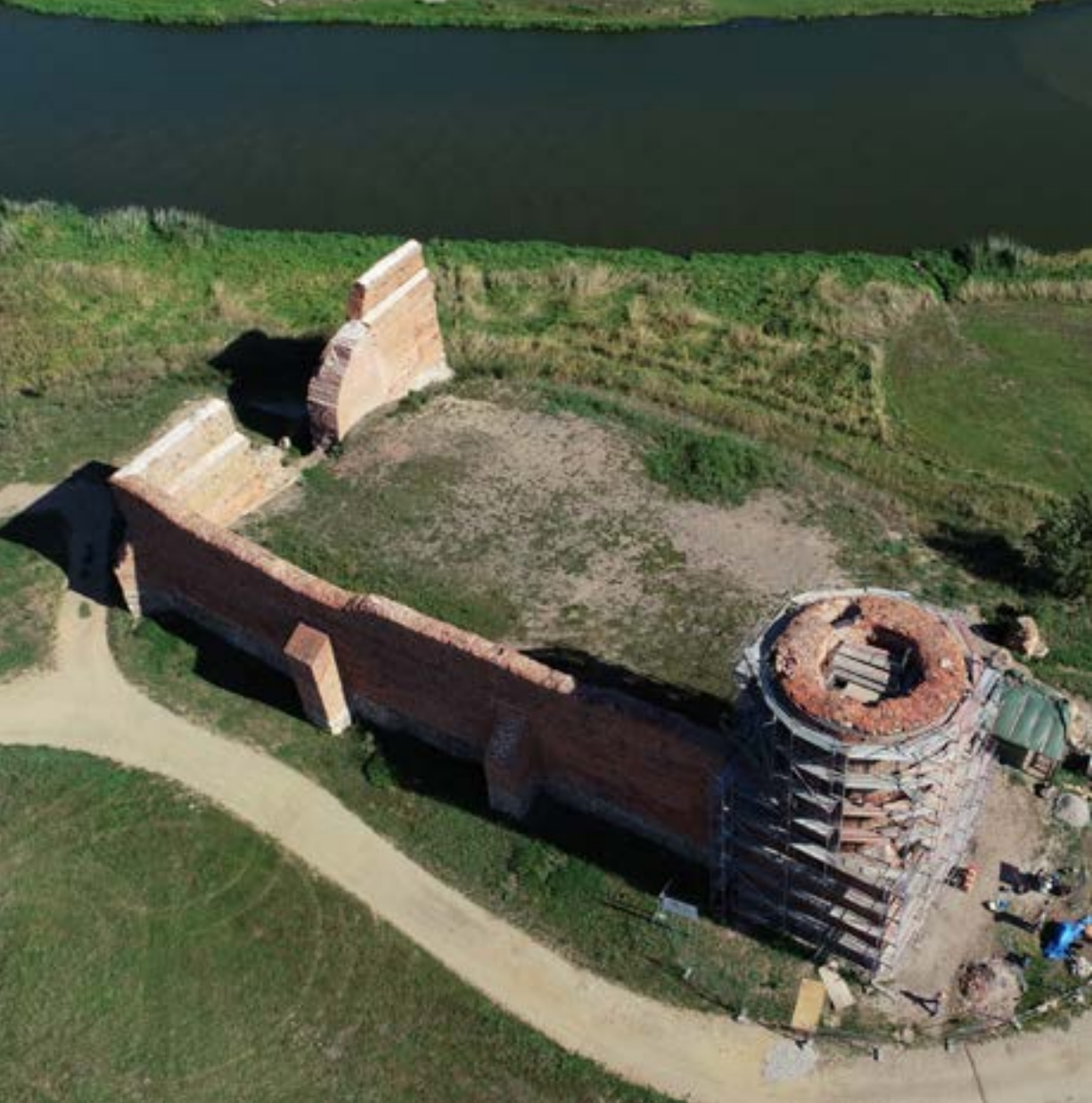
Prace konserwatorsko-budowlane przy baszcie narożnej (2023 r.).
