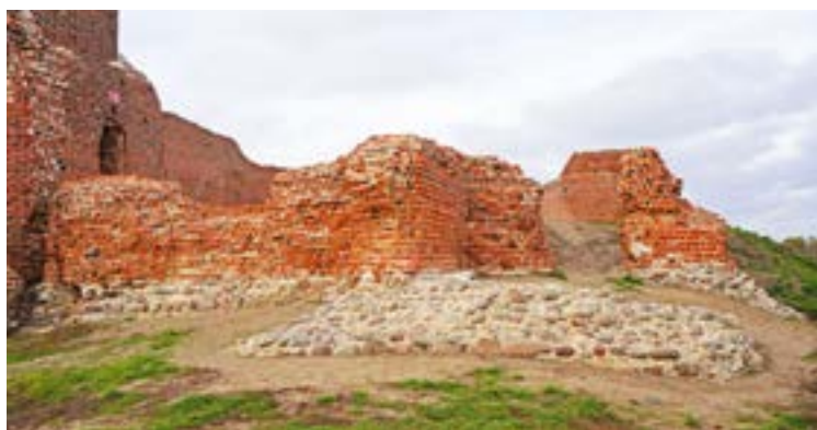
Mur południowy zamku wykonany w piątym etapie konserwacji (2024 r.)
