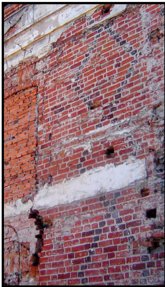
Odślonięta podczas remontu ściana ratusza z widocznym ornamentem.
