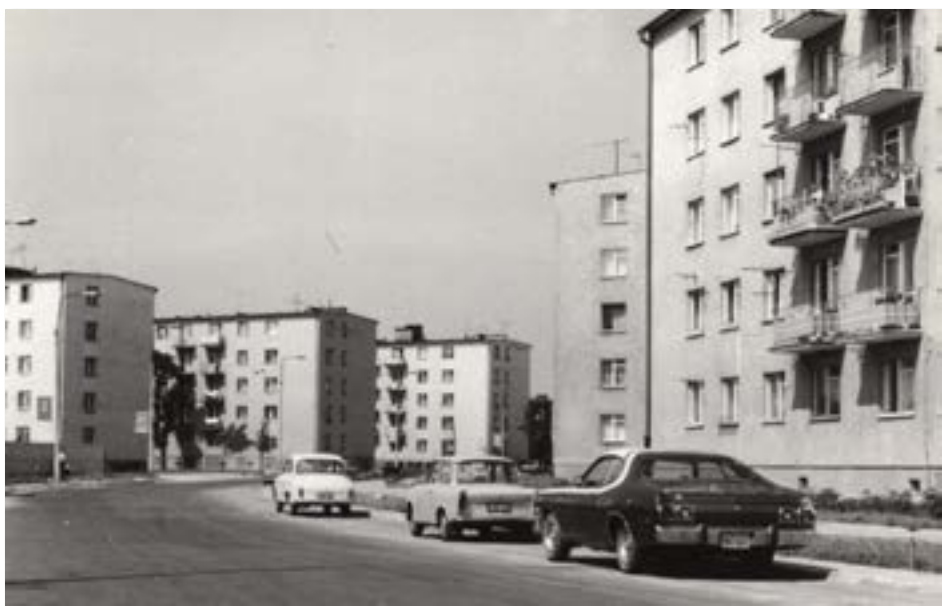
Widok na ul. Broniewskiego w kierunku ul. 20 Stycznia (lipiec 1975 r.).
