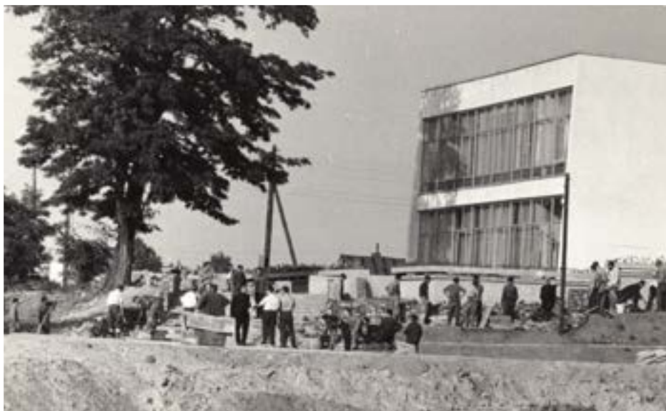
Prace wykończeniowe wokół nowo powstałego budynku Powiatowego Domu Kultury (obecnie Miejski Dom Kultury) – wrzesień 1970 r.
