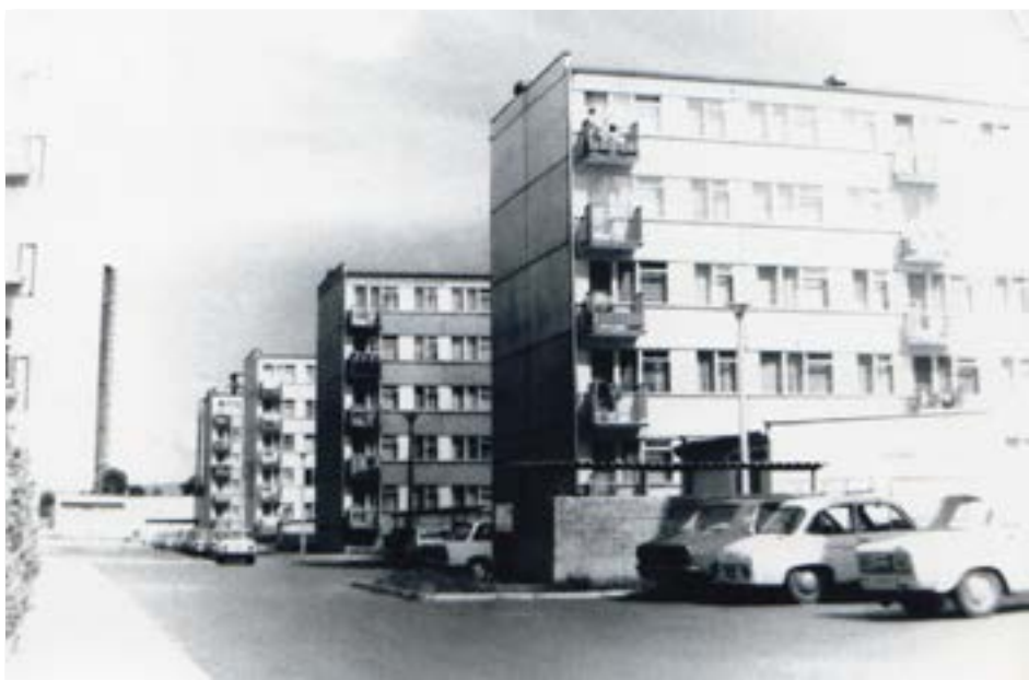
Osiedle Włocławska. Po lewej stronie w dalszej perspektywie widać budynek węzła ciepłego oraz pierwszy komin miejskiej kotłowni (II poł. lat 70-tych, lub pocz. lat 80-tych).
