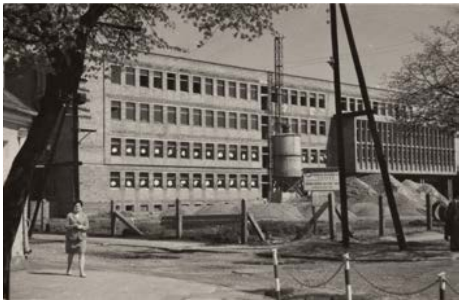
Budowa biurowca przy ul. Sienkiewicza (wiosna 1970 r.).
