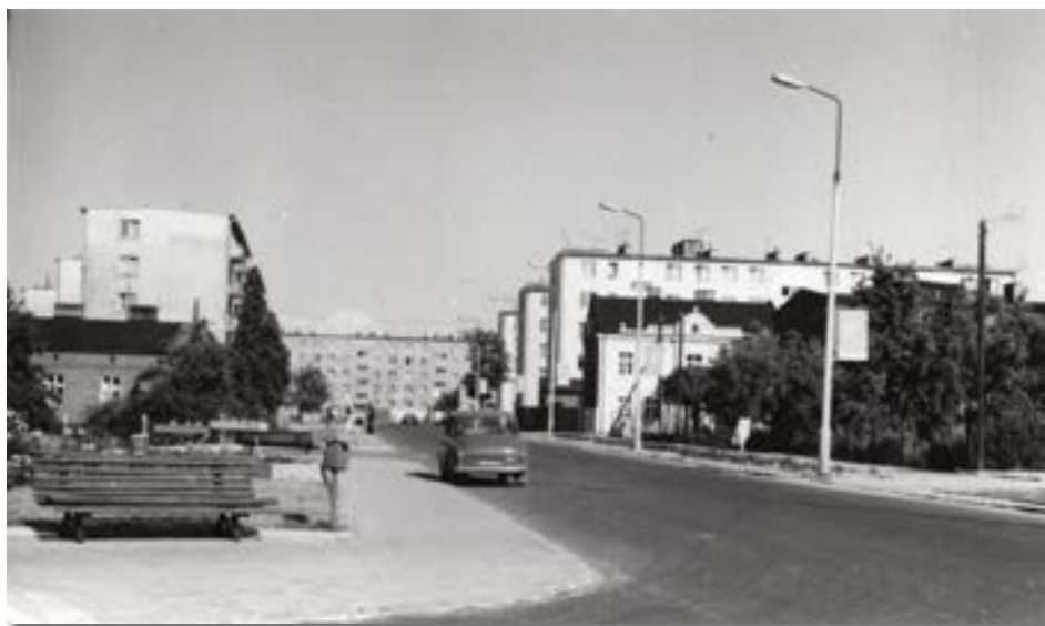
Ulica Broniewskiego z widokiem na skrzyżowanie z ul. 20 Stycznia. Po lewej stronie ceglany budynek, gdzie po przebudowie znajduje się obecnie kwaciarnia.
