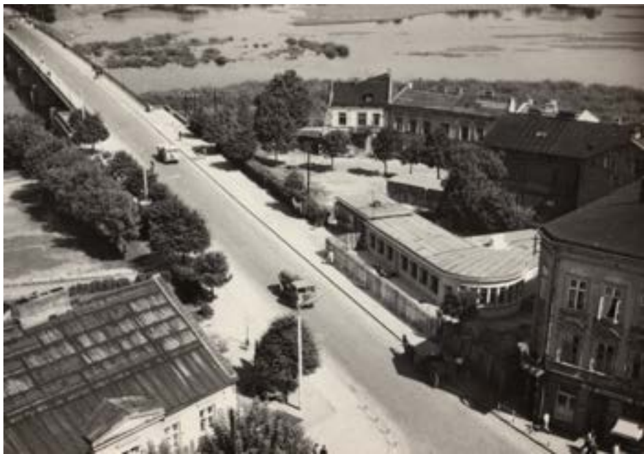
Widok na ul. Nowowarszawską i budowany pawilon handlowy.
