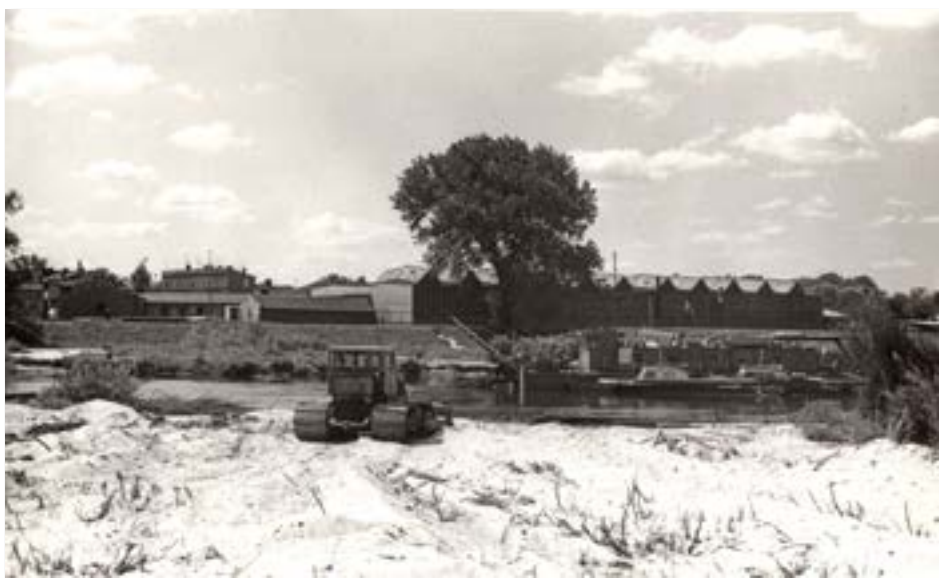
Prace przy rzece Warcie. Na drugim brzegu widać zabudowania Fabryki ZREMB (sierpień 1982 r.).
