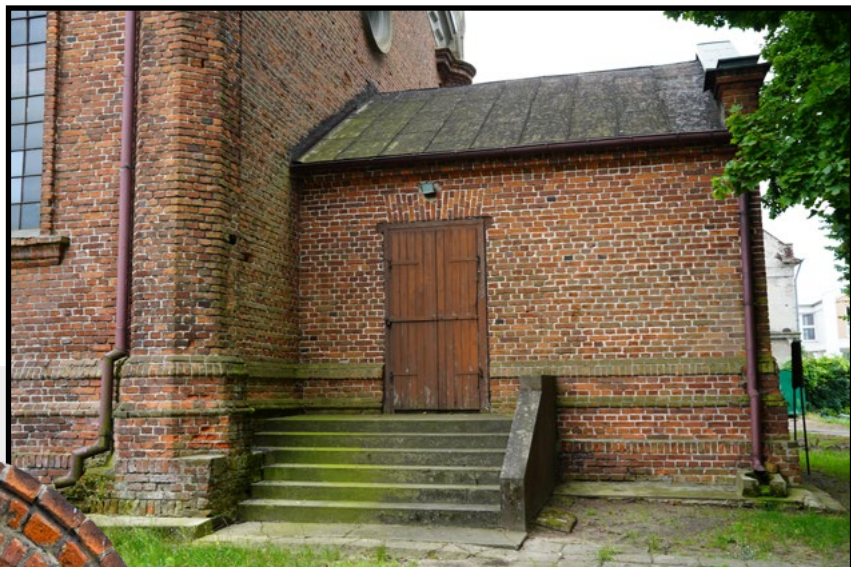
Wejście do zakrystii, którą umiejscowiono od ulicy Zielonej.
