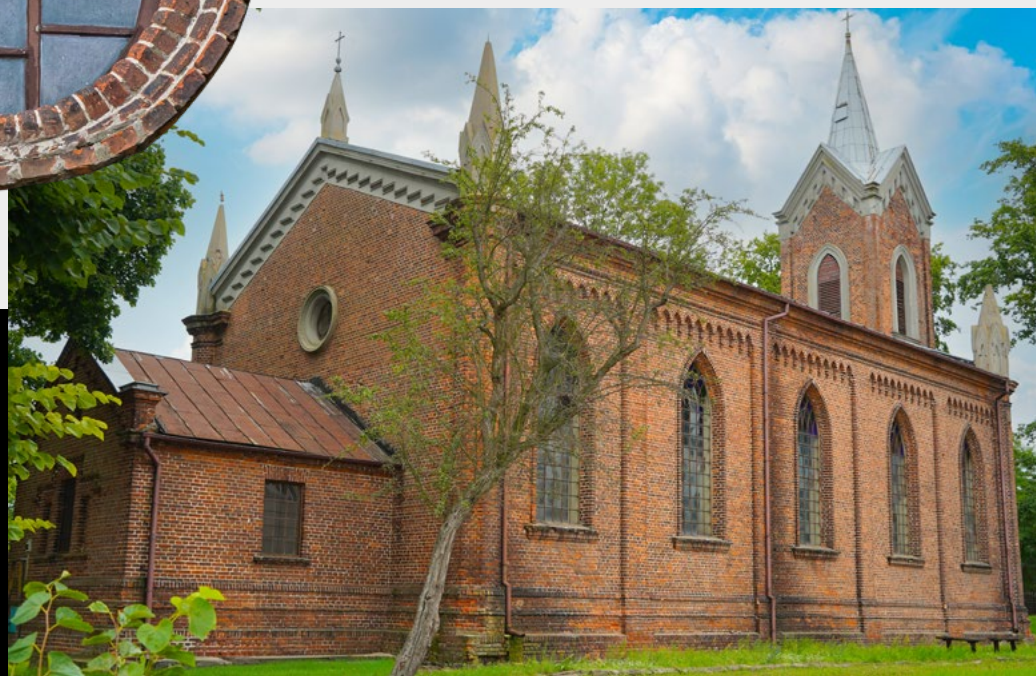
Widok od strony południowo-zachodniej.
