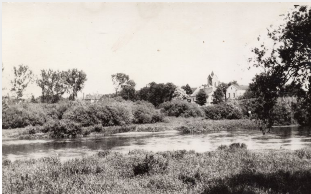
Zdjęcie z połowy lat 60-tych. Widać uszkodzoną wieżę kościoła. Ze zbiorów Piotra Śniegockiego.
