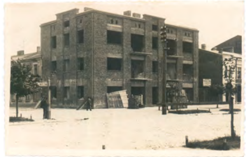
Budynek na ulicy Sienkiewicza w budowie (obecnie siedziba Kom. Pow. Policji). „Studio-Film”, A. Stupay, Koło. Do 1939 r. Ze zbiorów Pana Krzysztofa Szymańskiego.
