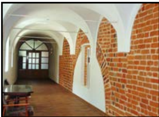
O średniowiecznej genezie klasztoru w Kole świadczą odkryte fragmenty murów z ciosów kamiennych i cegły w układzie gotyckim.
