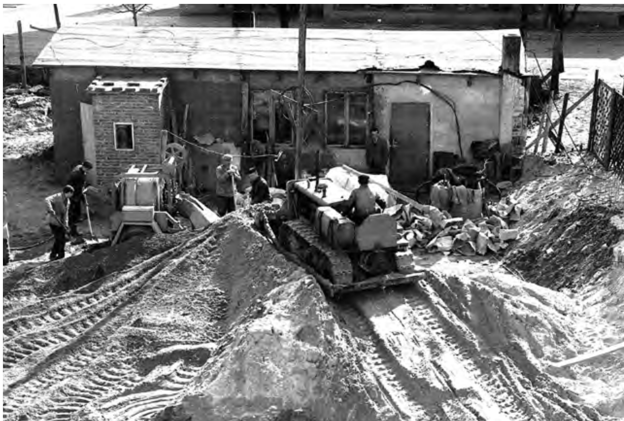
Budowa hotelu zakładowego.
