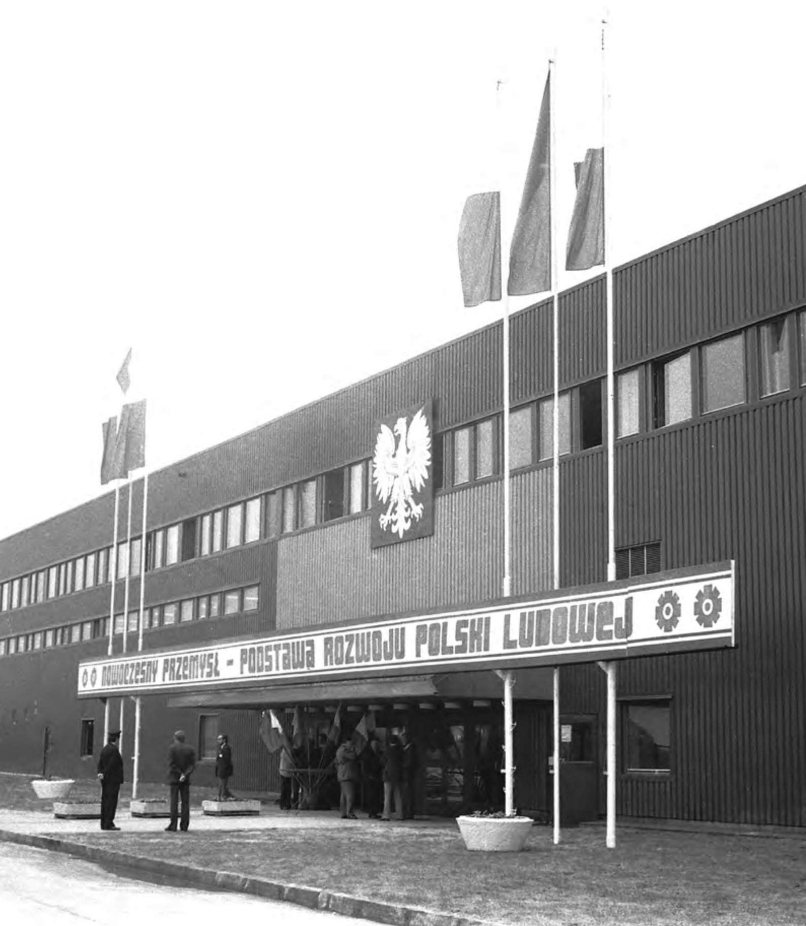
Budynek Wydziału Tarcz Ściernych P-4.
