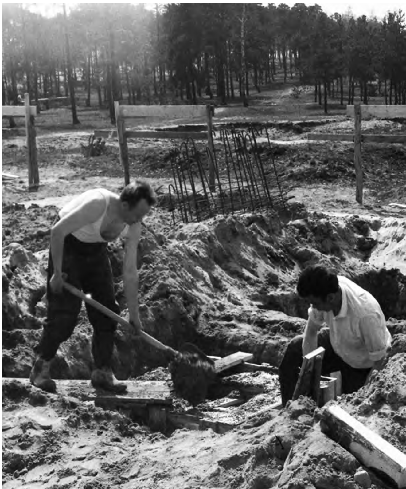
Prace przy fundamentach pod pierwsze budynki zakładu.
