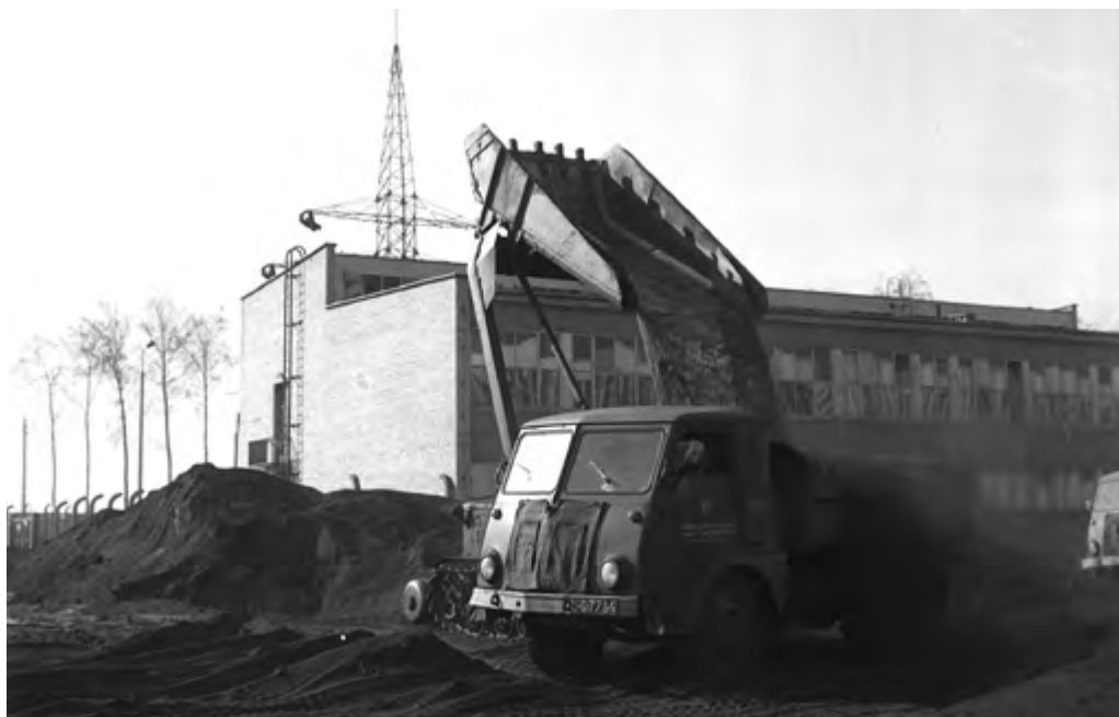
Prace budowlane na terenie powstającego Wydziału Elektrokorundu.
