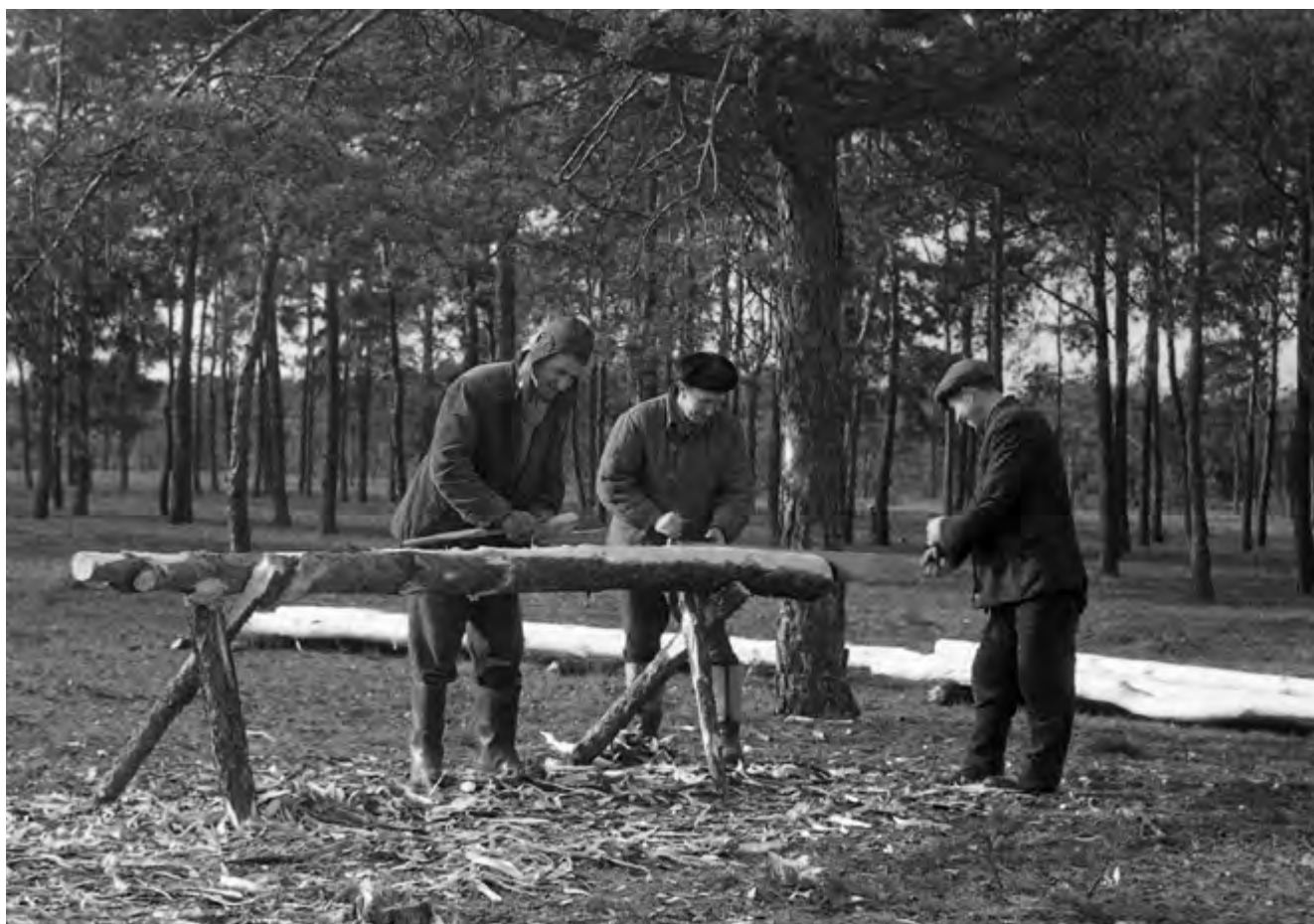
Prace przy odwiercie studni.
