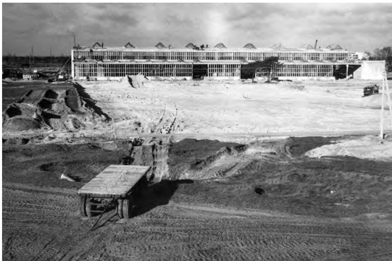
Niwelacja terenu i budowa hali Wydziału Węglika Krzemu.
