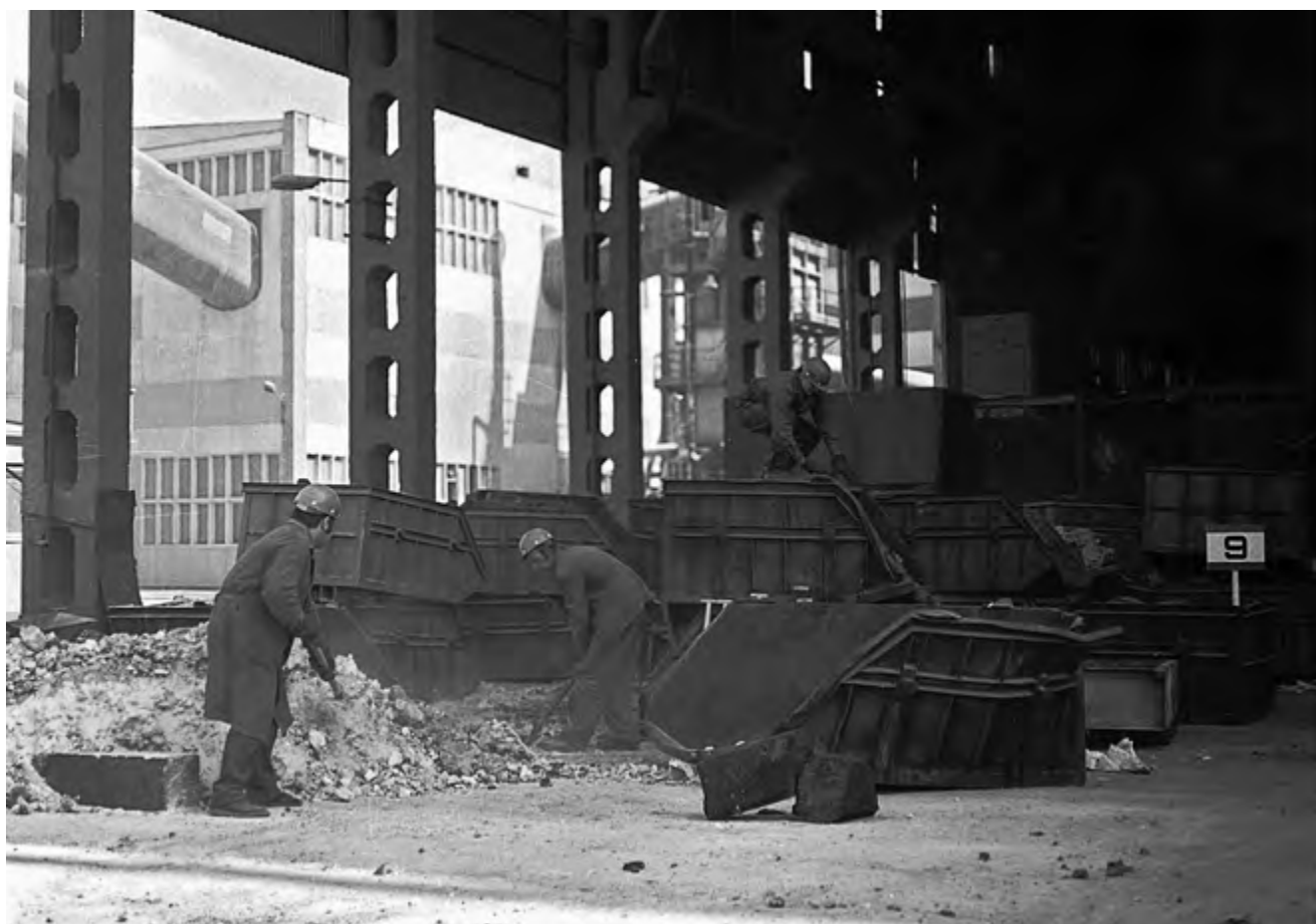
Ładowanie klinkieru.
