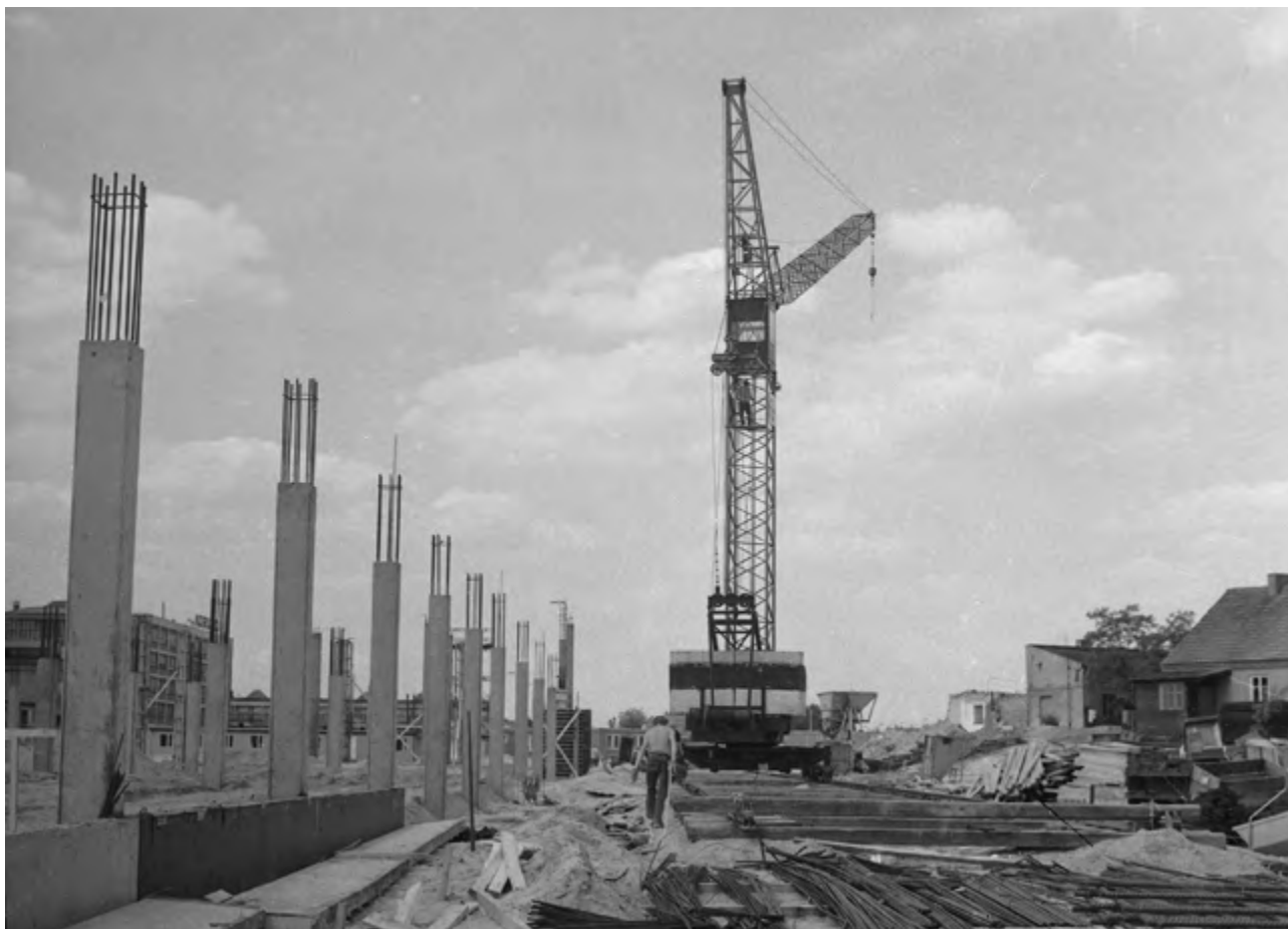
Budowa hali wydziału tarcz ściernych P-4.
