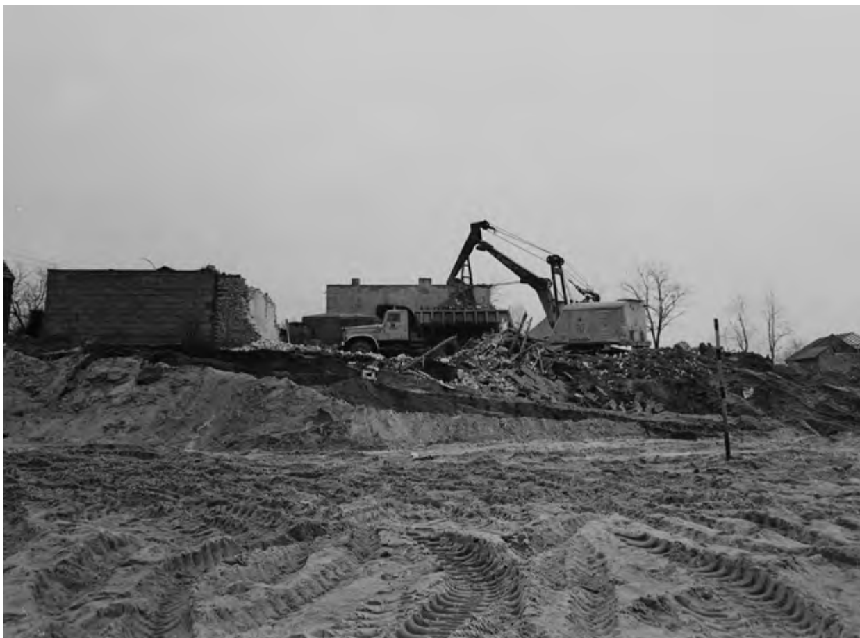
Rozpoczęcie budowy i niwelacja terenu pod wydziel P-4.
