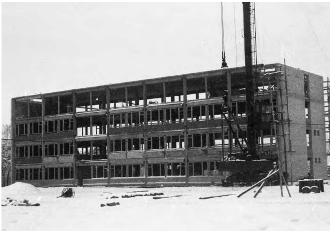
Budynek administracji w budowie.
