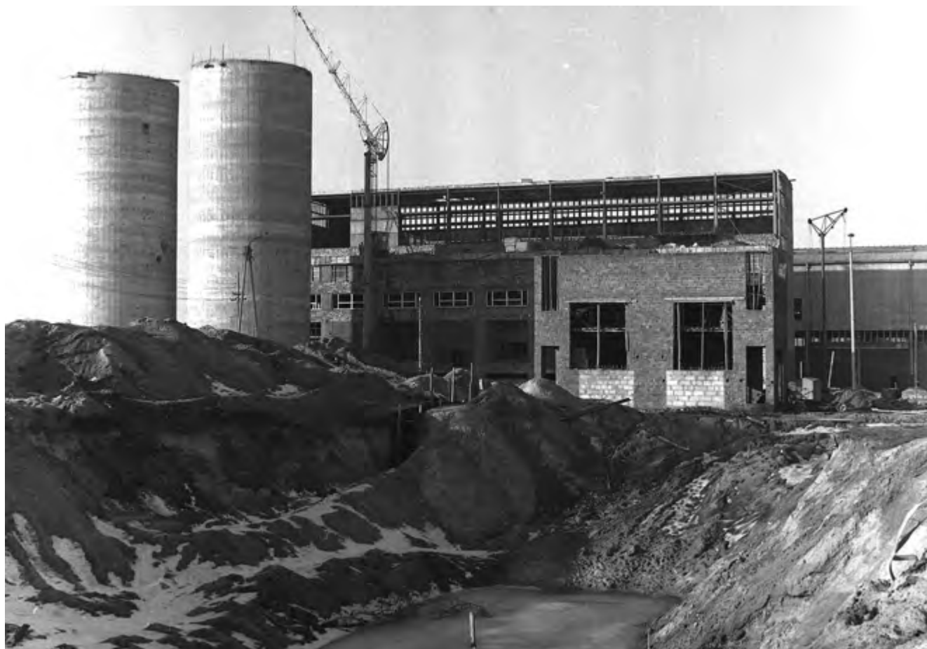
Silosy do magazynowania surowców (boksytu i tlenku glinu).
