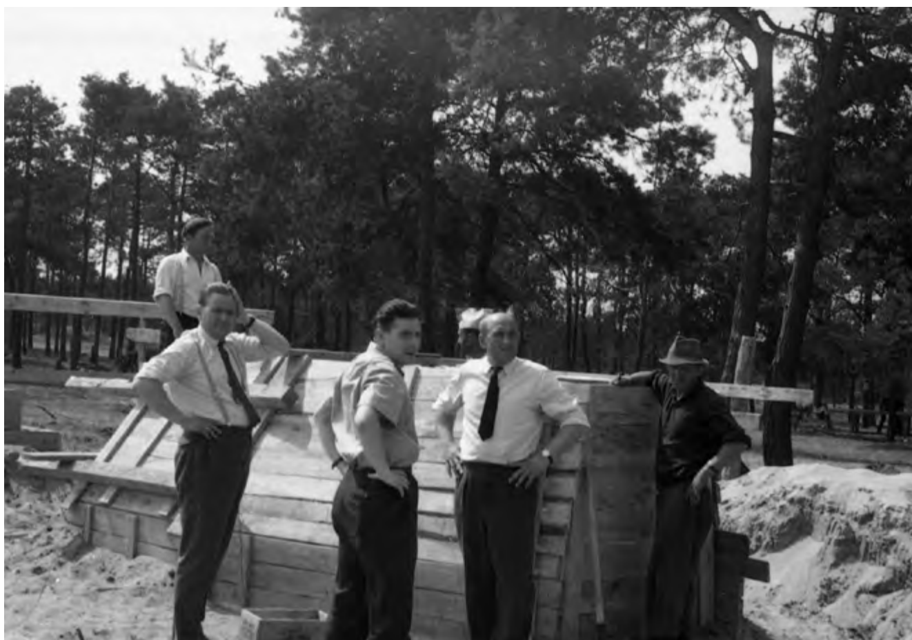
Wizytacje zakładu w czasie budowy.
