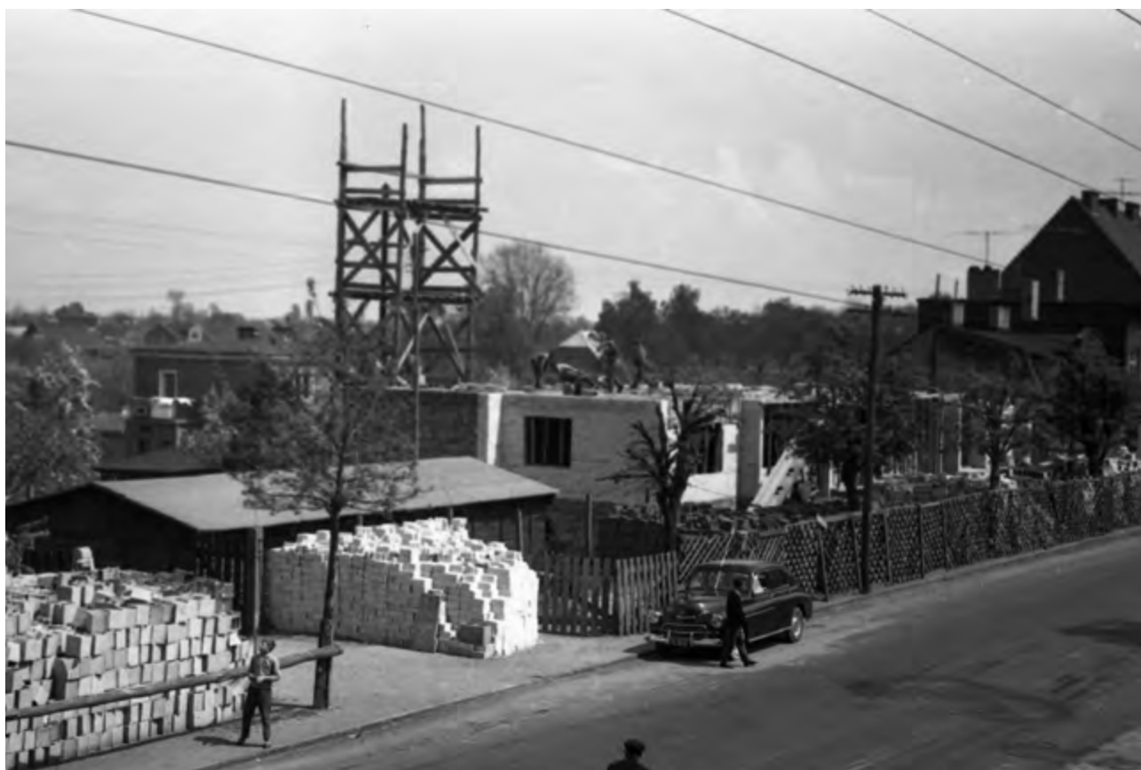
Widok budowy bloku zakładowego przy ulicy Toruńskiej.
