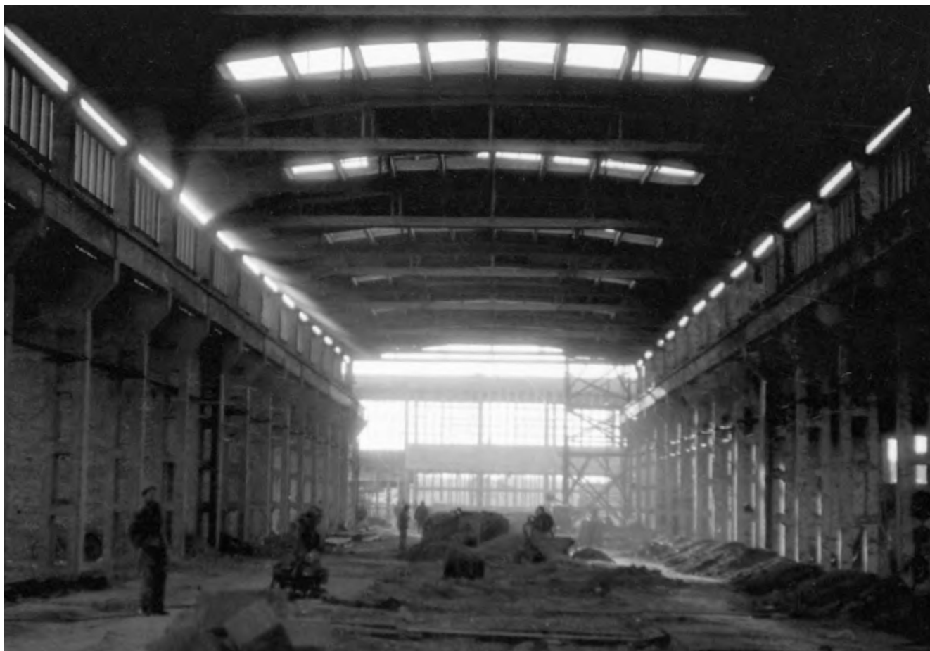
Hala Wydziału Remontowego.
