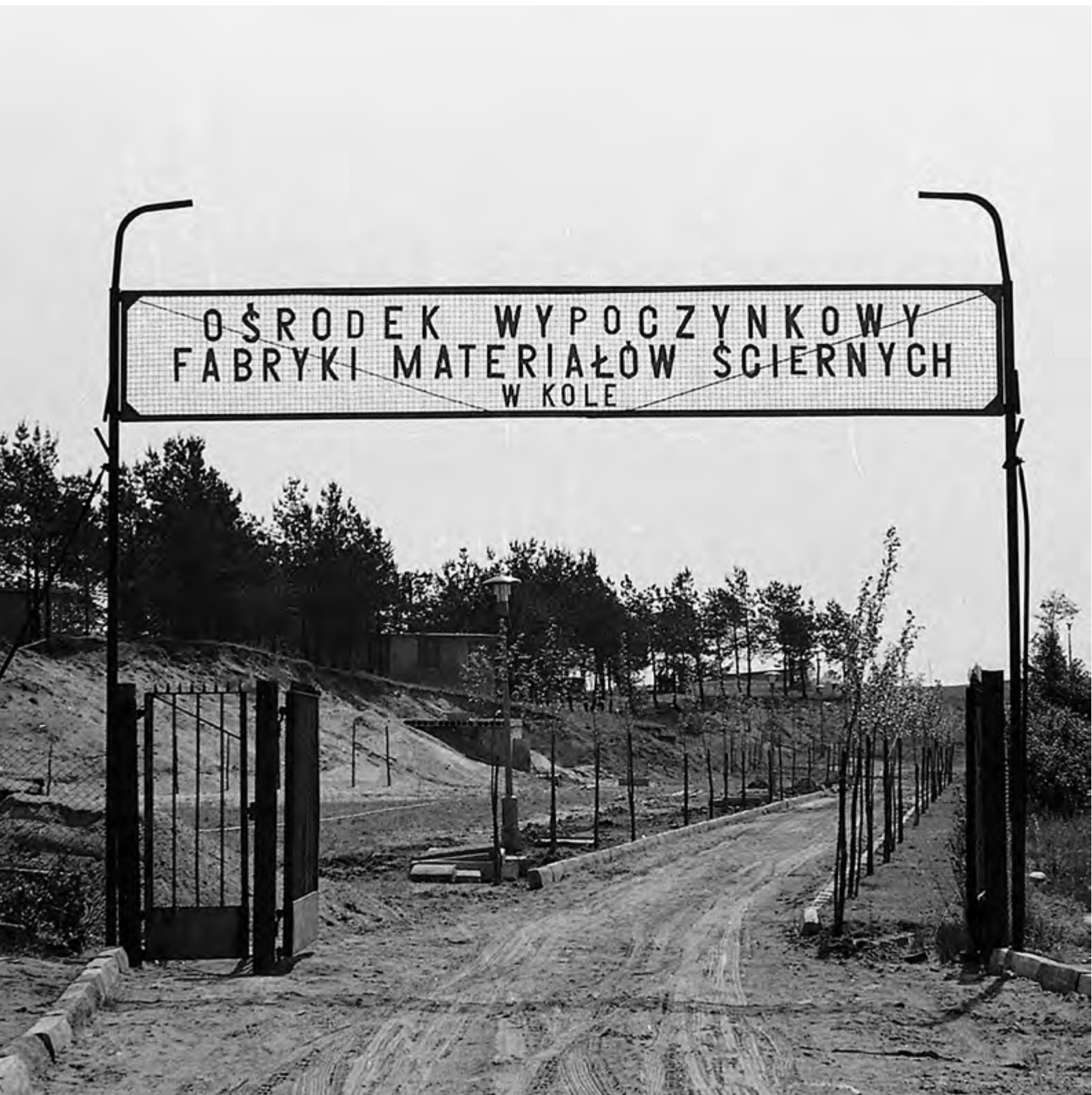
Ośrodek wypoczynkowy w Mąkolnie. Rozpoczęcie budowy.
