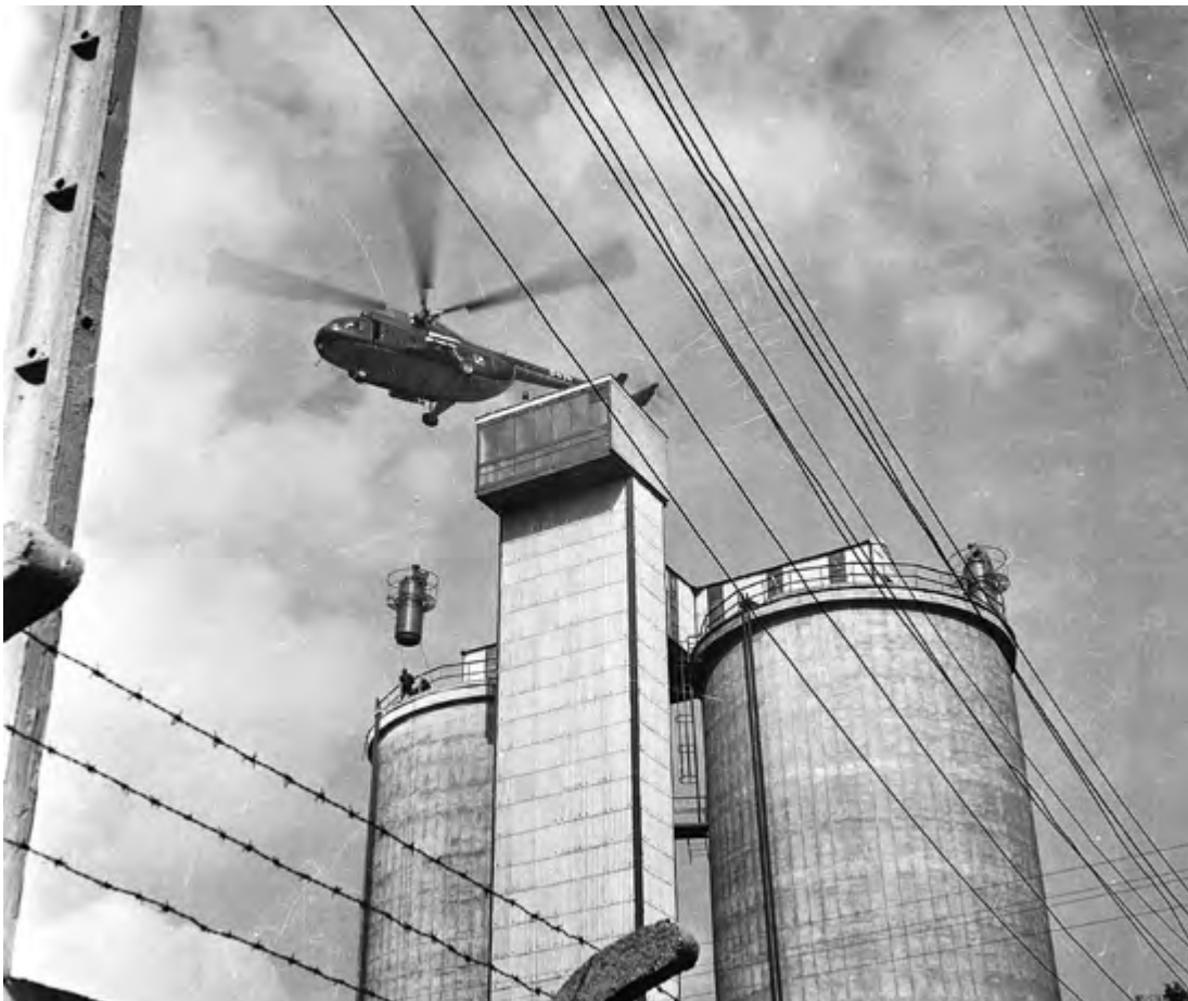
Instalacja głowicy filtru na silosie tlenku glinu.
