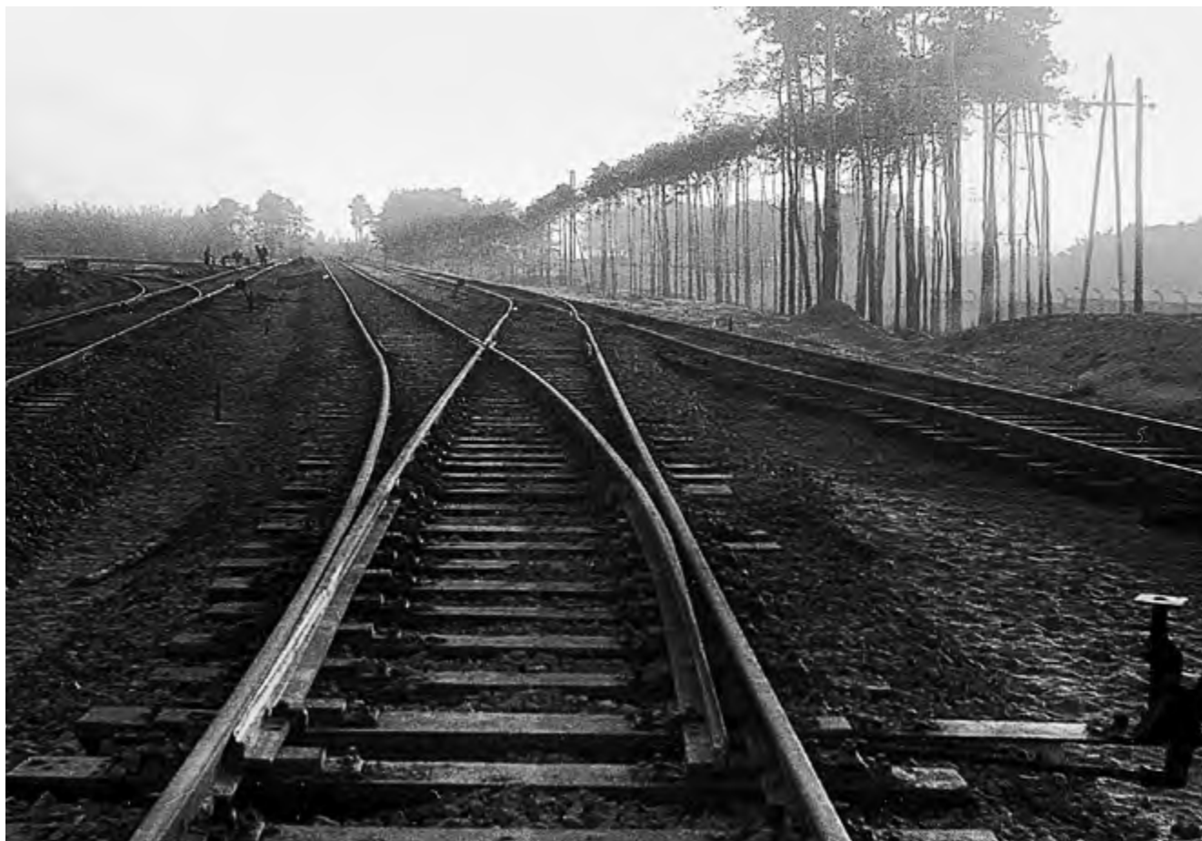
Bocznicą kolejową na terenie zakładu.
