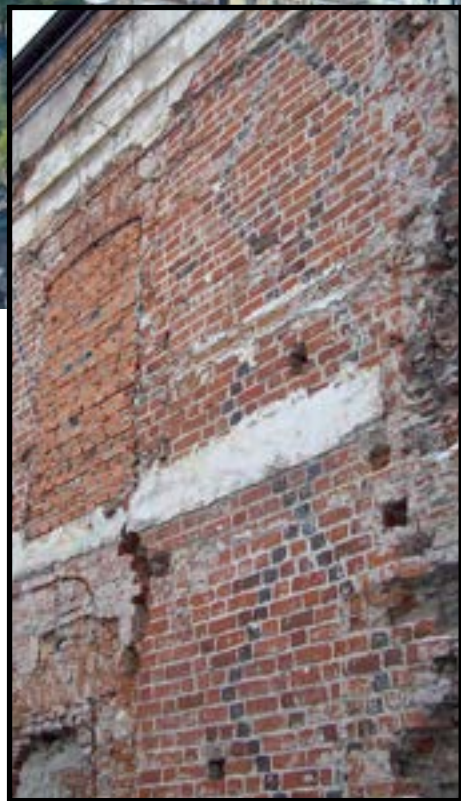
Fragment zachodniego muru ratusza odsłonięty podczas prac budowlanych. Wyraźnie widoczny ornament rombowy z cegieł zendrówek.
